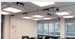
Iluminação de escritório
